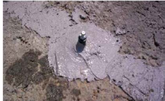
Рисунок 2. Герметизация пакера, установленного на поверхности и трещины при использовании соответствующего средства MasterBrace/MasterFlow
